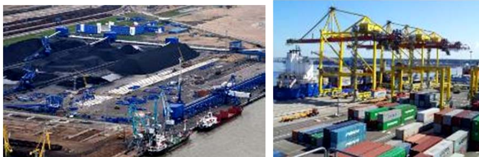
Рисунок 3 – Терминалы порта Усть-Луга: угольный и контейнерный слева направо
